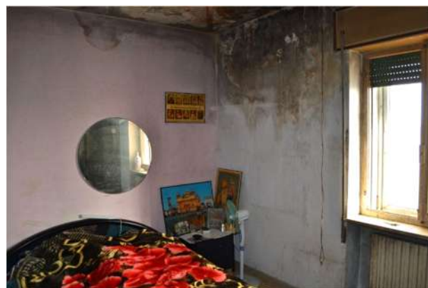
foto 11 - sub 5 (letto 1) – Le membrature d'ambito si presentano fortemente ammalorate soprattutto sul lato attiguo al soggiorno e al cucinino. Le mufte, pur prevalentemente nere, non sono tutte inattive.
