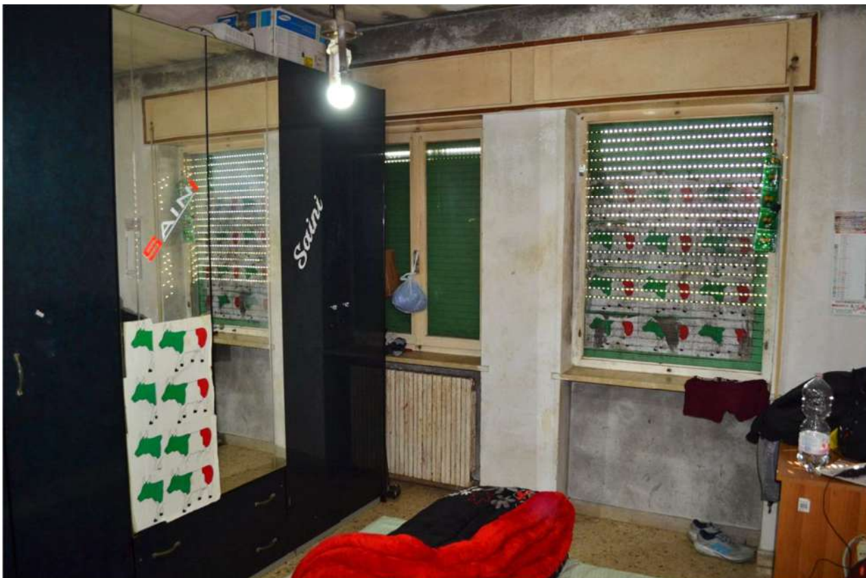
foto 4 – m.n. 632 (264) sub 5 (letto 2) – Anche nell'unica camera da letto singola (misura 12,62 m 2 ) si riscontrano estesi aloni di muffa nera – per cui inattiva al momento dell'ispezione, ma riattivabile in caso di ripresa dell'irrorazione. Mancano una finestra e un corpo scaldante sotto davanzale (infixo a destra in foto).
