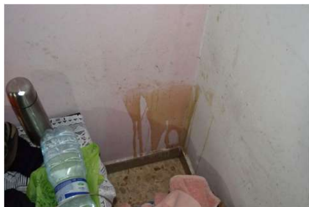
foto 13 - sub 5 (letto 2) – Oltre agli ammaloramenti da incuria pluridecennale, già diffusamente descritti, nell'angolo di stanza contiguo al vano scale si vede una colatura di sporcizia versata sulla parte bassa del muro in comune con la u.i.u. sub 6. L'abitazione non è verosimilmente mai stata ritinteggiata.
