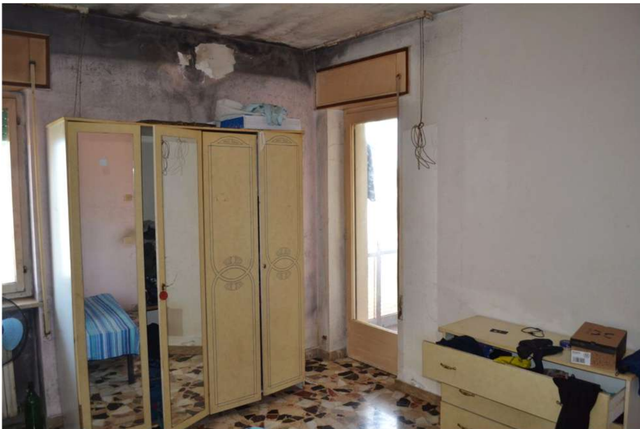
foto 3 – m.n. 632 (264) sub 5 (letto 3) – Tutto l'appartamento si trova in condizioni di manutenzione a dir poco scadenti. Oltre a risentire di marcata vulnerabilità lungo i ponti termici, l'involucro superiore lascia trafilare l'acqua piovana: la combinazione dei due difetti – uno costitutivo e l'altro accidentale – col tempo ha reso muri e soffitti delle distese di muffa. I corpi scaldanti sono termosifoni a bassa inerzia termica; i pavimenti sono in quadroni alla simil-palladiana (come qui) o alla simil-veneziana (come in soggiorno o nella camera da letto di cui alla foto successiva).
