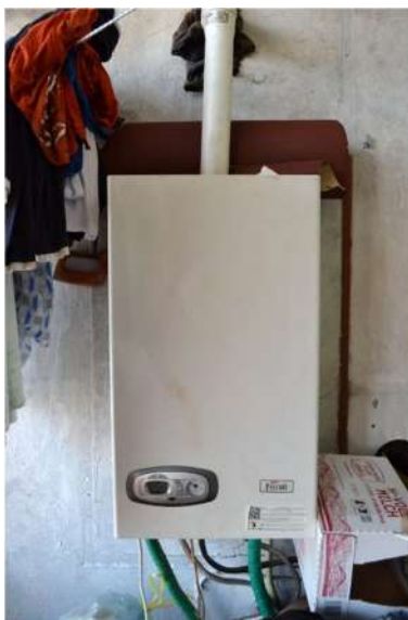
foto 17 - sub 5 (loggia) - Il generatore di calore pare una caldaia Ferroli da 24 kW. L'esecutato non sa riferire eventuali estremi di accatastamento CIRCE.
