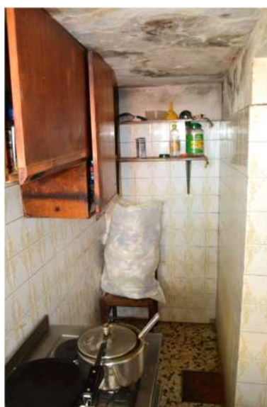
foto 8 - sub 5 (cucinino) - Anche qui il soffitto lascia trapelare notevoli infiltrazioni ristagnanti di acqua piovana, dando luogo ad aloni di aspetto molto risalente.
