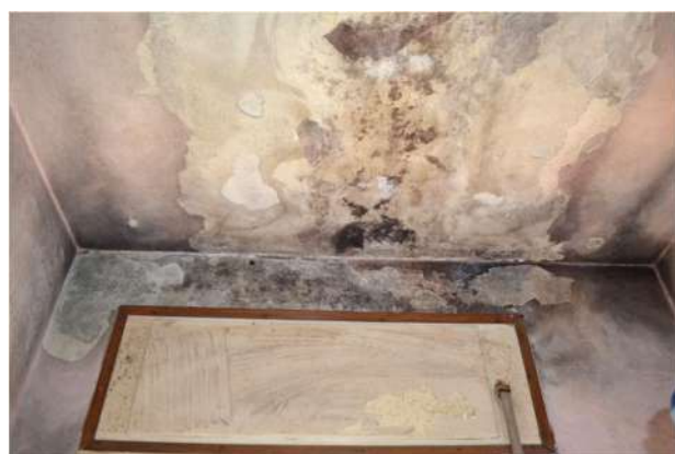
foto 15 - sub 5 (bagno) – Le mufte sopra il cassonetto dell'avvolgibile sono multicolori, variando dal nero al verde al giallastro: segno che le micocolture sono attive, cioè correntemente irrorate.
