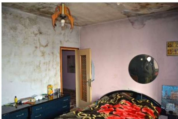
foto 12 - sub 5 (letto 1) – La stanza da letto principale ha problemi di umidità residua anche sul muro che la divide dal bagno. La porta interna, secondo lo standard tipologico prevalente nell'abitazione, ha il contorno in legno tamburato verniciato e la luce centrale in vetro stampato.
