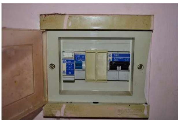
foto 14 - sub 5 (ingresso con disbrigo) – Il quadro elettrico generale dell'appartamento, in apparenza datato, ha la I_{\Delta n} del differenziale correttamente tarata (3 mA) e un solo magnetotermico da 15 A.
