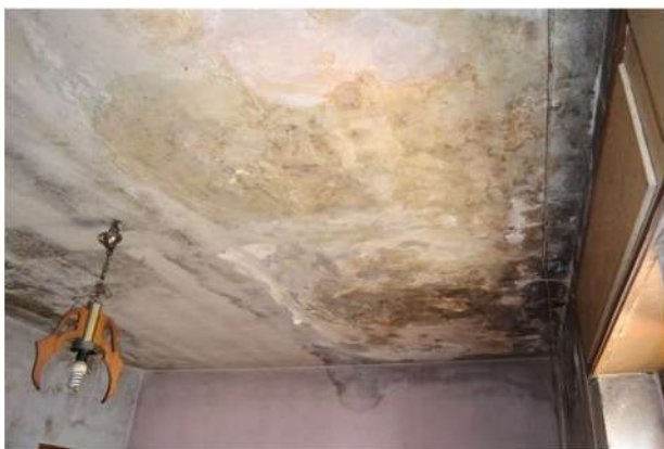
foto 19 - sub 5 (letto 1) - Anche nella stanza da letto più grande si vedono muffe intradossali di molti colori, per cui di attività e alimentazione variabili – probabilmente – in ragione della loro diversa prossimità ai punti di maggiore irrorazione a riva di copertura.
