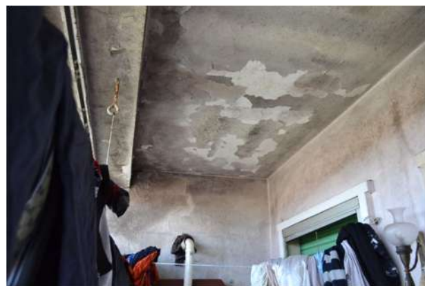
foto 6 - sub 5 (loggia) – Anche il vano finestrato di interposizione tra il soggiorno e il poggiolo mostra evidenza di protratte infiltrazioni d'acqua. Il tubo bianco in basso, al centro, è l'espulsione fumi della caldaia murale (vedi foto n. 17). Il contorno dell'infisso è sormontato da una trave d'ambito fuori spessore.
